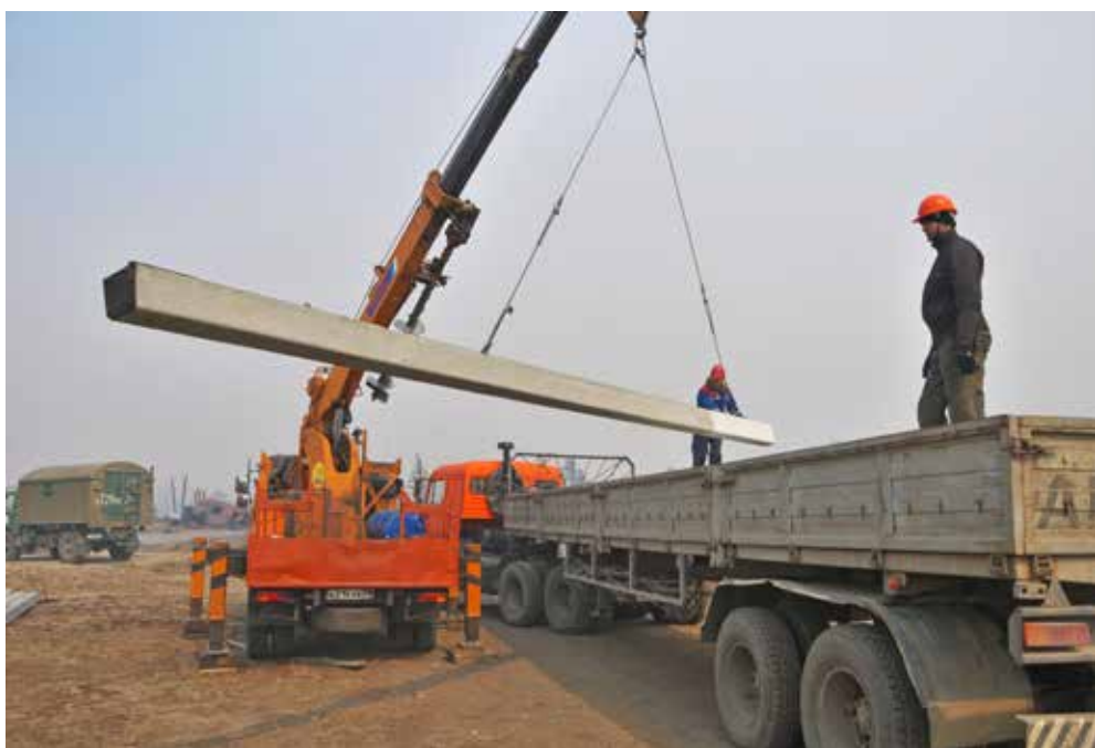
Строительство сетей в с. Тыгда, 2012 г.
