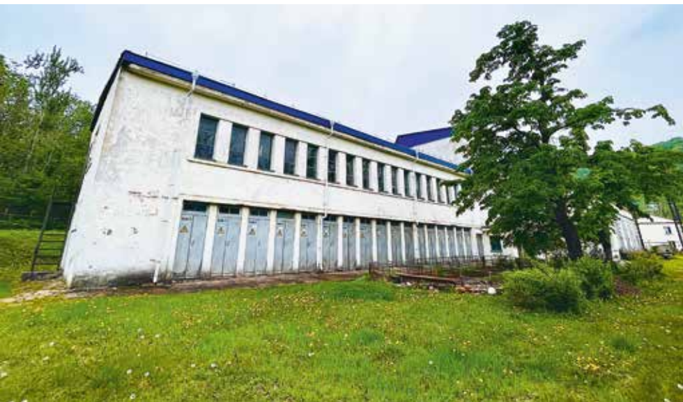
Подстанция «КЭТ» построена в 70-е годы
