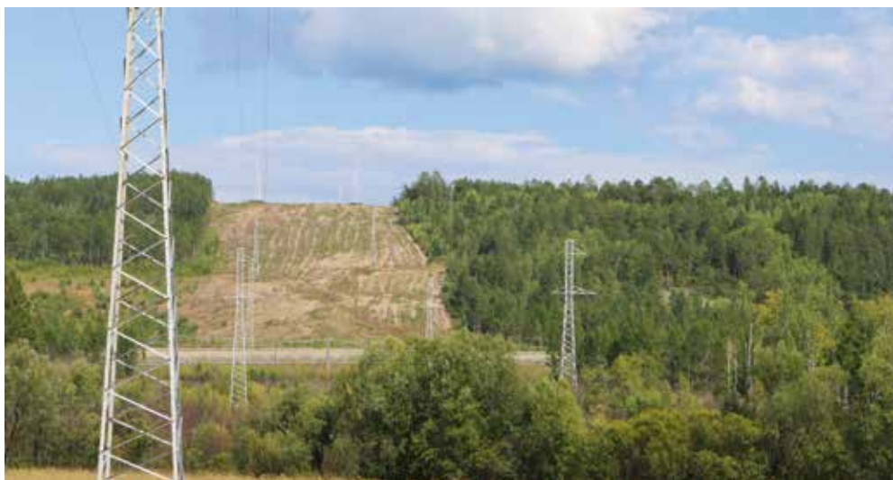
Новые ЛЭП в Сковородинском районе
