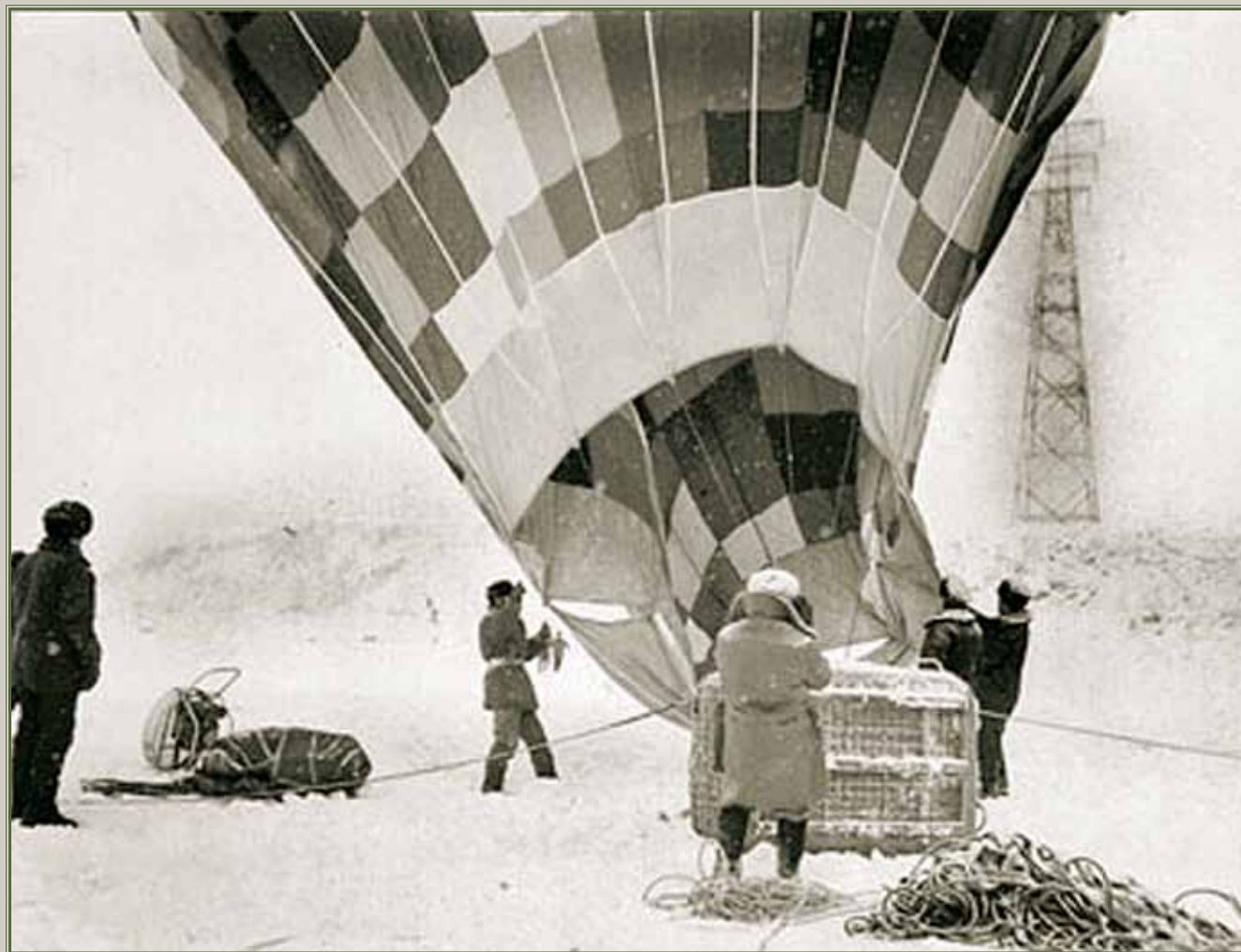
Энергетикам нужно срочно провести ремонт ЛЭП над Амуром. Идет подготовка воздушного шара
