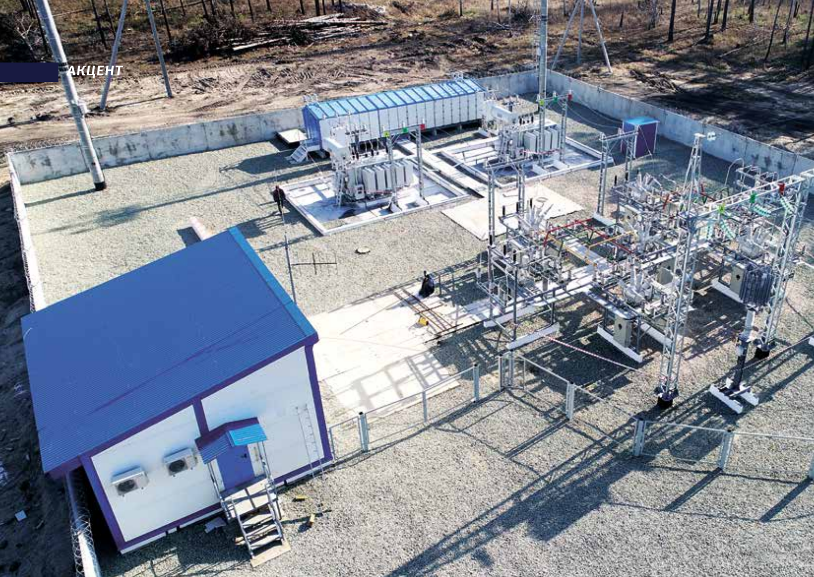
Введена в работу ПС «Заводская»
