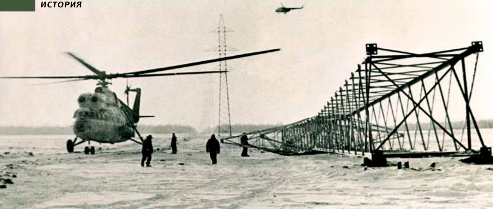
Строительство ЛЭП 220 кВ «Хабаровск-Комсомольск»
