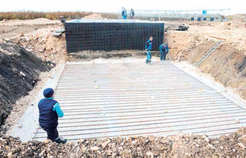
Монтаж фундамента для силового трансформатора на ПС «Дубки»
