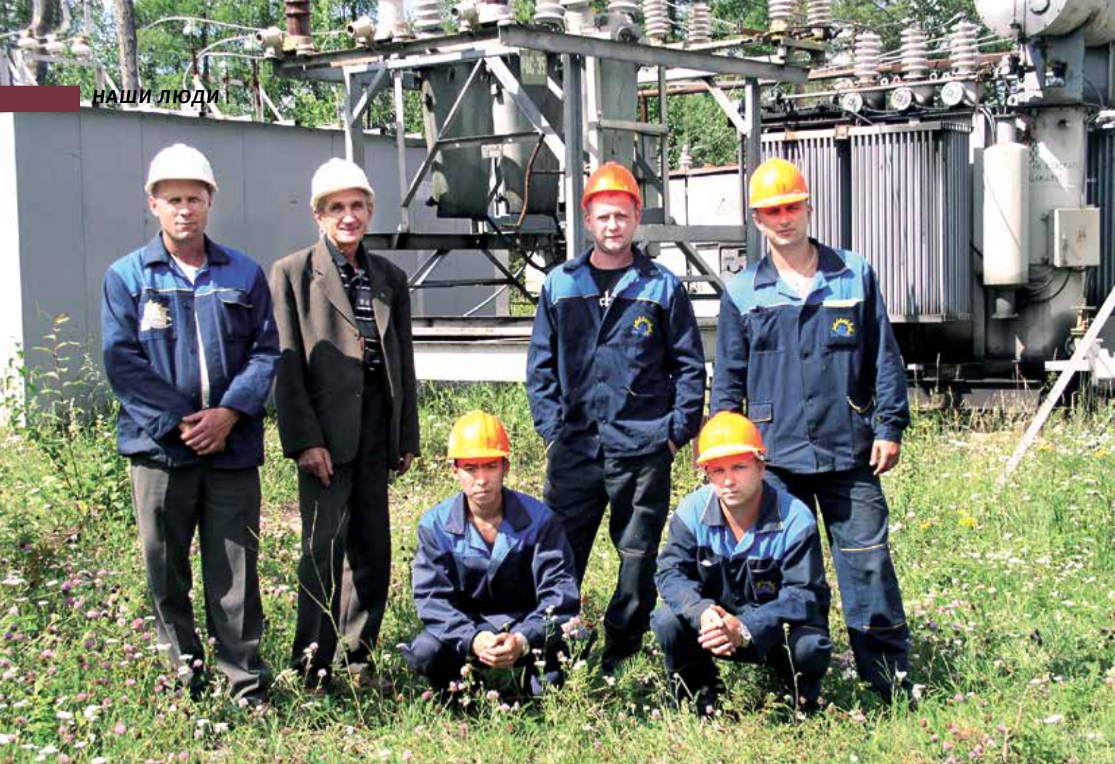
А. С. Павленок вместе с оперативно-выездной бригадой ТРЭС на ПС № 12 проводят монтажные работы
