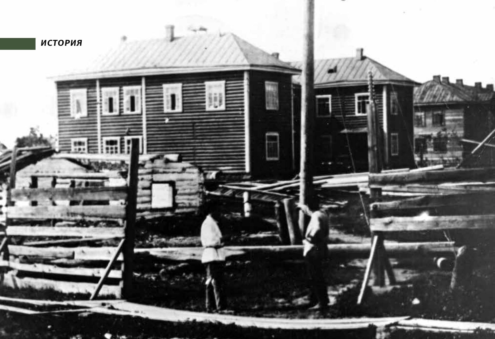
Строительство Биробиджана. Улица Ленина. 1935 г.
