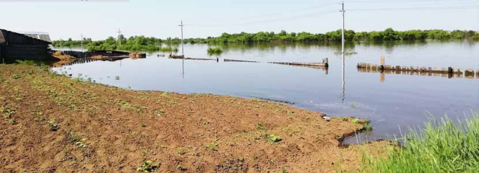
Ф4-10 ПС 35 кВ «Воскресеновка». 24.06.2021 г.
