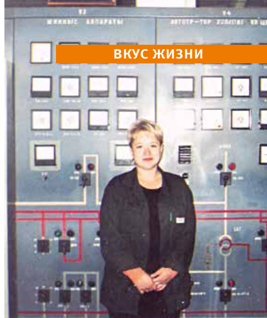
ДЭМ ПС-220 кВ «Мирный»
