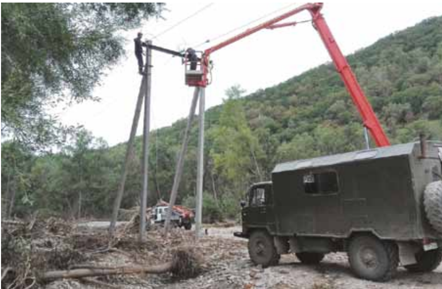
Восстановление энергоснабжения п. Горноводное, Ольгинский район
