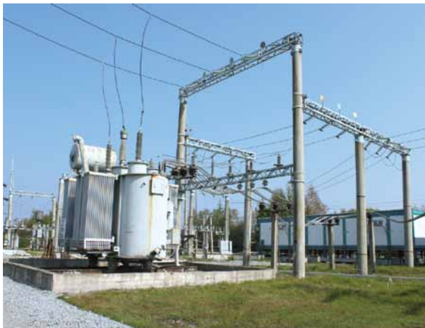
Идет реконструкция ПС 100/35/6 кВ «ГВФ» для надежного энергоснабжения аэропорта г. Хабаровск, который станет одним из крупнейших авиаузлов международного значения на Дальнем Востоке
