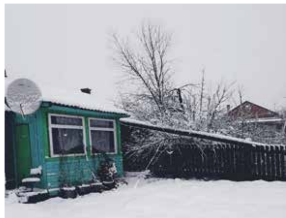
Бригада Тонких восстановила электроснабжение села Харпичан
