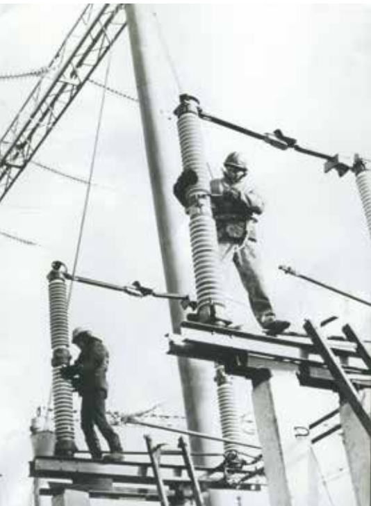
монтаж разъединителей 220 кВ пс Уссурийск-2
