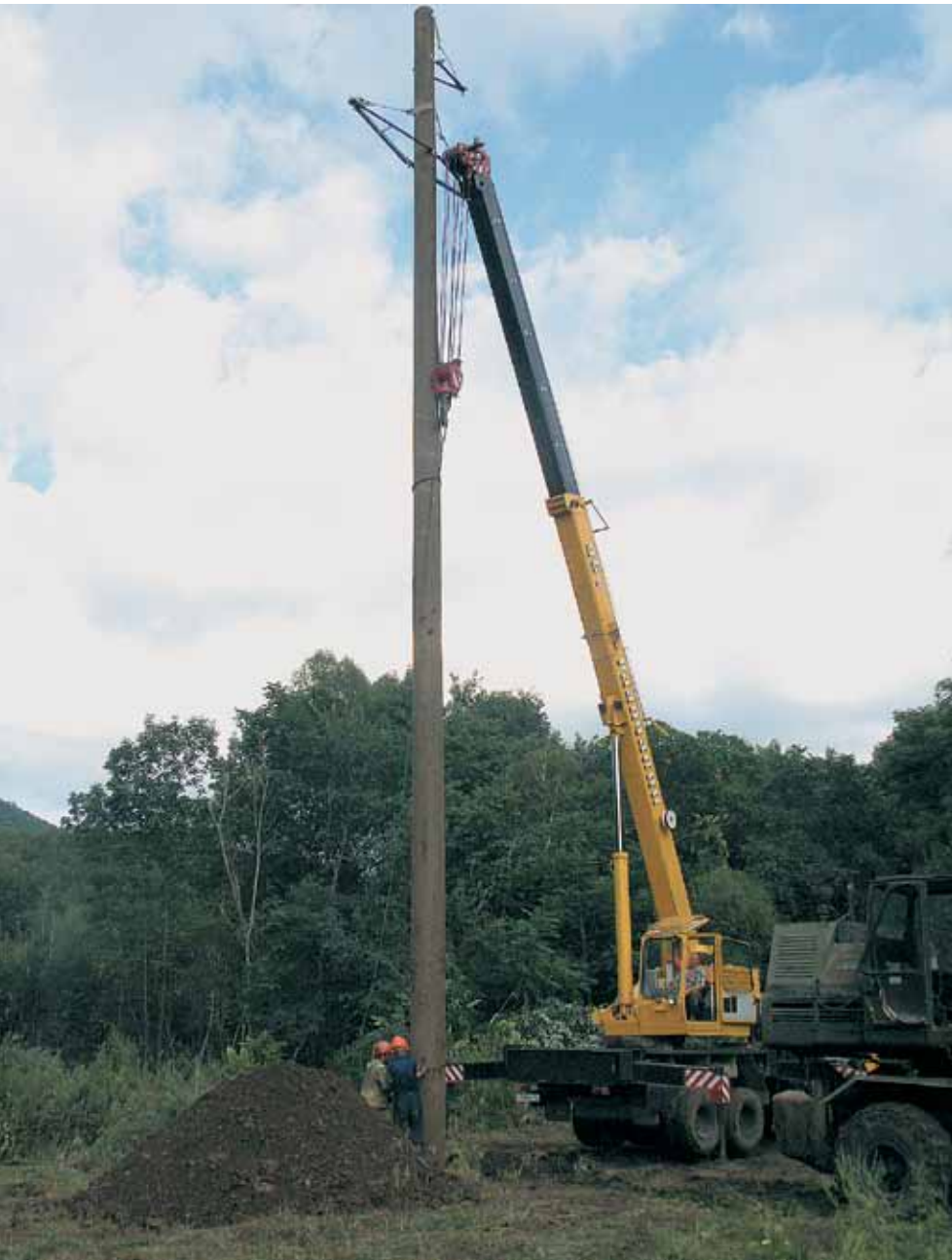
Идет восстановление ЛЭП, разрушенной тайфуном
